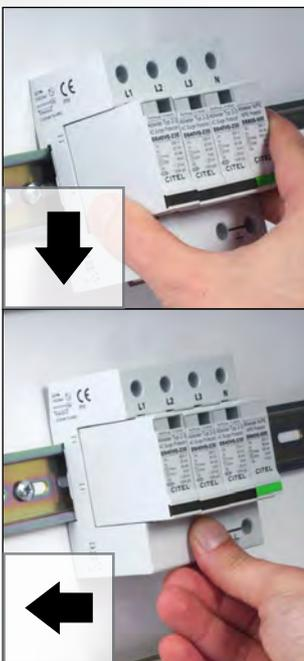
Posicionar la protección en la parte superior del carril DIN, y empujarla en su parte inferior para clipsar.
